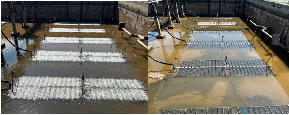
Рис. 2. Внутрішній вигляд реактора SBR: аераційна решітка та система випуску надосадової води після ремонту
