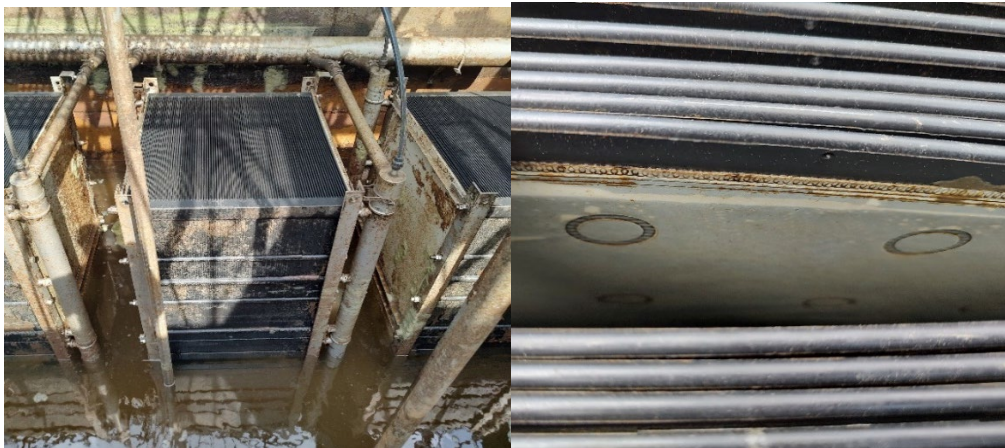
Рис. 3. Розміщення занурювальних мембранних блоків безпосередньо в технологічному об'ємі реактора MBR
