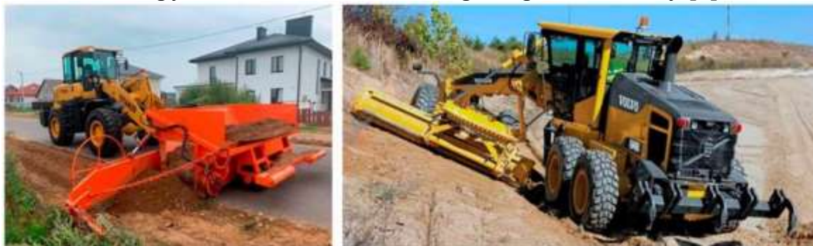
Рис. 1. Робота під час укладання та розширення дорожніх узбіч.
