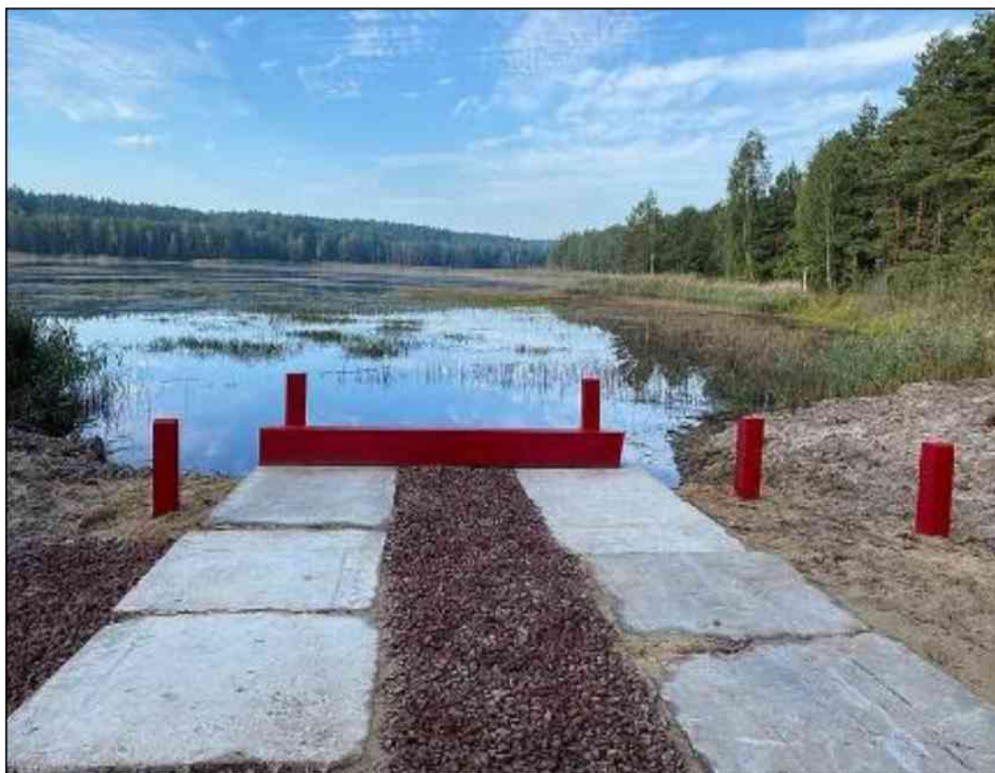
Рис. 2.13. Приклад облаштування водозабірної майданчика з поглибленням дна на березі озера
