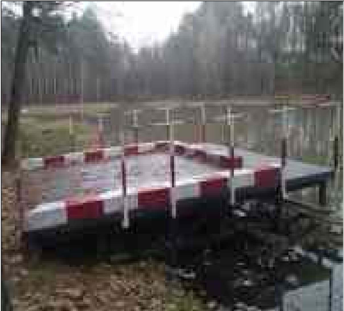
Рис. 2.12. Приклад облаштування водозабірної майданчика з поглибленням дна на березі ставка
