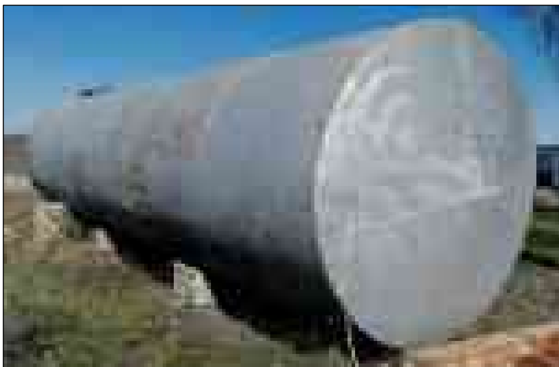
Рис. 2.16. Пожежний резервуар для забору води обсягом 50 т
