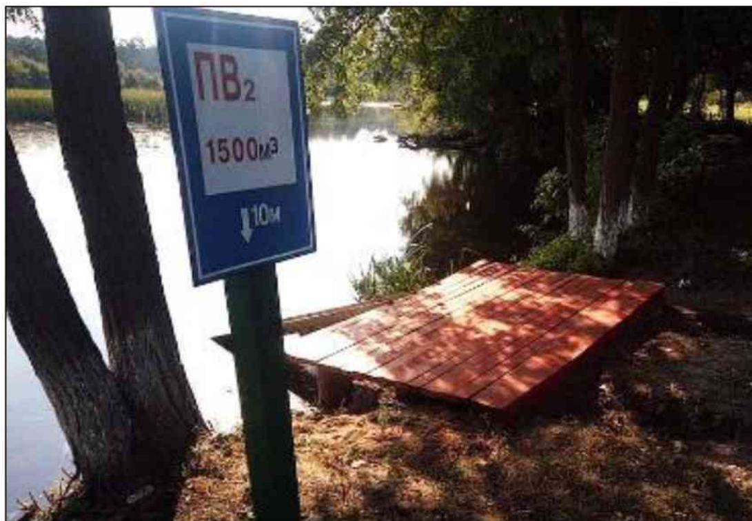
Рис. 2.14. Приклад облаштування пожежної водойми на березі озера з розміщенням спеціального інформаційного знака відповідно до ДСТУ (ДСТУ 3534-97, 1997)
