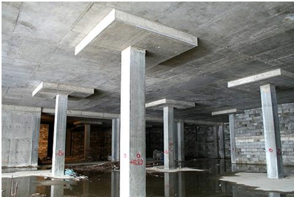
Рисунок 1 – Підсилення колон за допомогою капітелей
