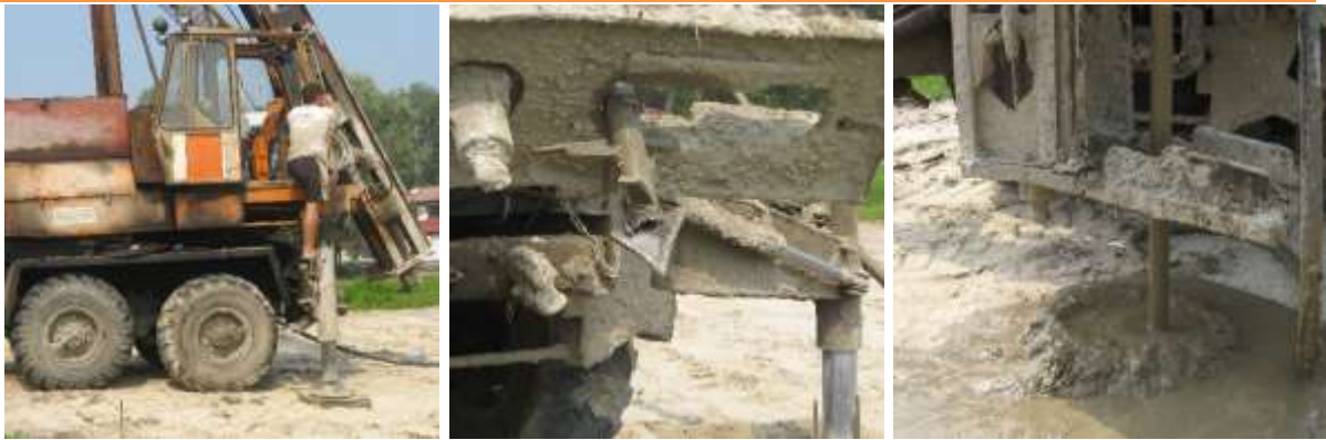
Рисунок 1 - Бурозмішувальна технологія виготовлення ґрунтоцементу
