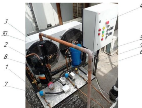
Рис. 4. Компресорно-конденсаторний агрегат. 1 – суцільнозварна рама, 2 – холодильний компресор спірального типу, 3 – конденсатор, 4 – блок керування, 5 – ресивер, 6 – запобіжне реле, 7,8 – соленоїдні клапани подачі сконденсованого холодоагента, 9 – соленоїдний клапан подачі гарячого газу, 10 – антикислотний фільтр, на лінії всмоктування.
