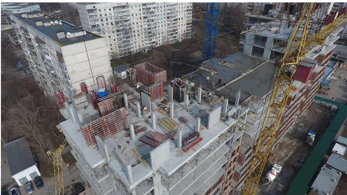
Рис.1. Доставка монолітного бетону на будівельний майданчик
