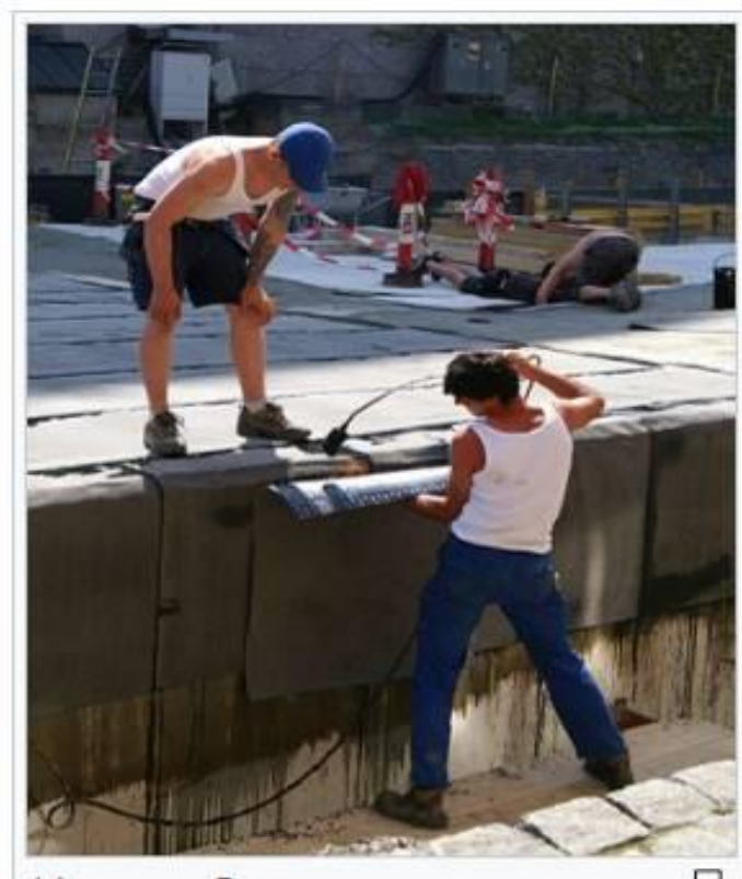
Рис.2. Монтаж обклеювальної гідроізоляції з листового бітуму
