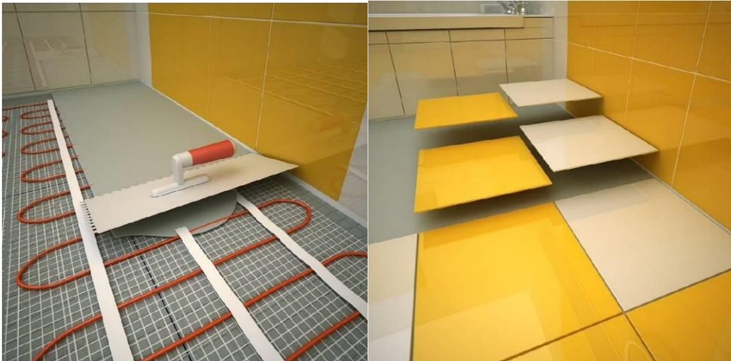
Рис.3. Нанесення клею та укладання плитки
