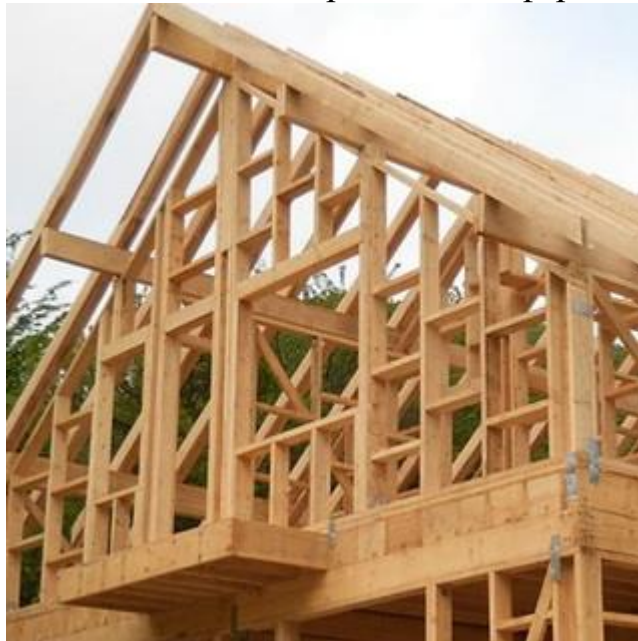
Рис.1. Будівля з дерев'яних клеєних конструкцій (ДКК).
