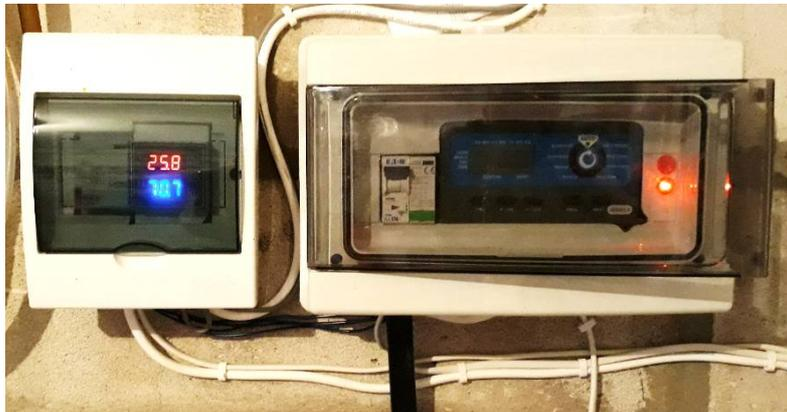
*Рисунок 2 – Блок керування системою охолодження корівника*
