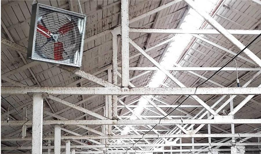
*Рисунок 1 – Загальний вигляд елементів системи охолодження корівника*
