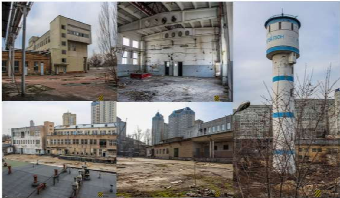
Рис.2. Молочний завод «Галактон» розміщений в межах житлової забудови міста Києва (з весни 2016 року не функціонує) [5].
